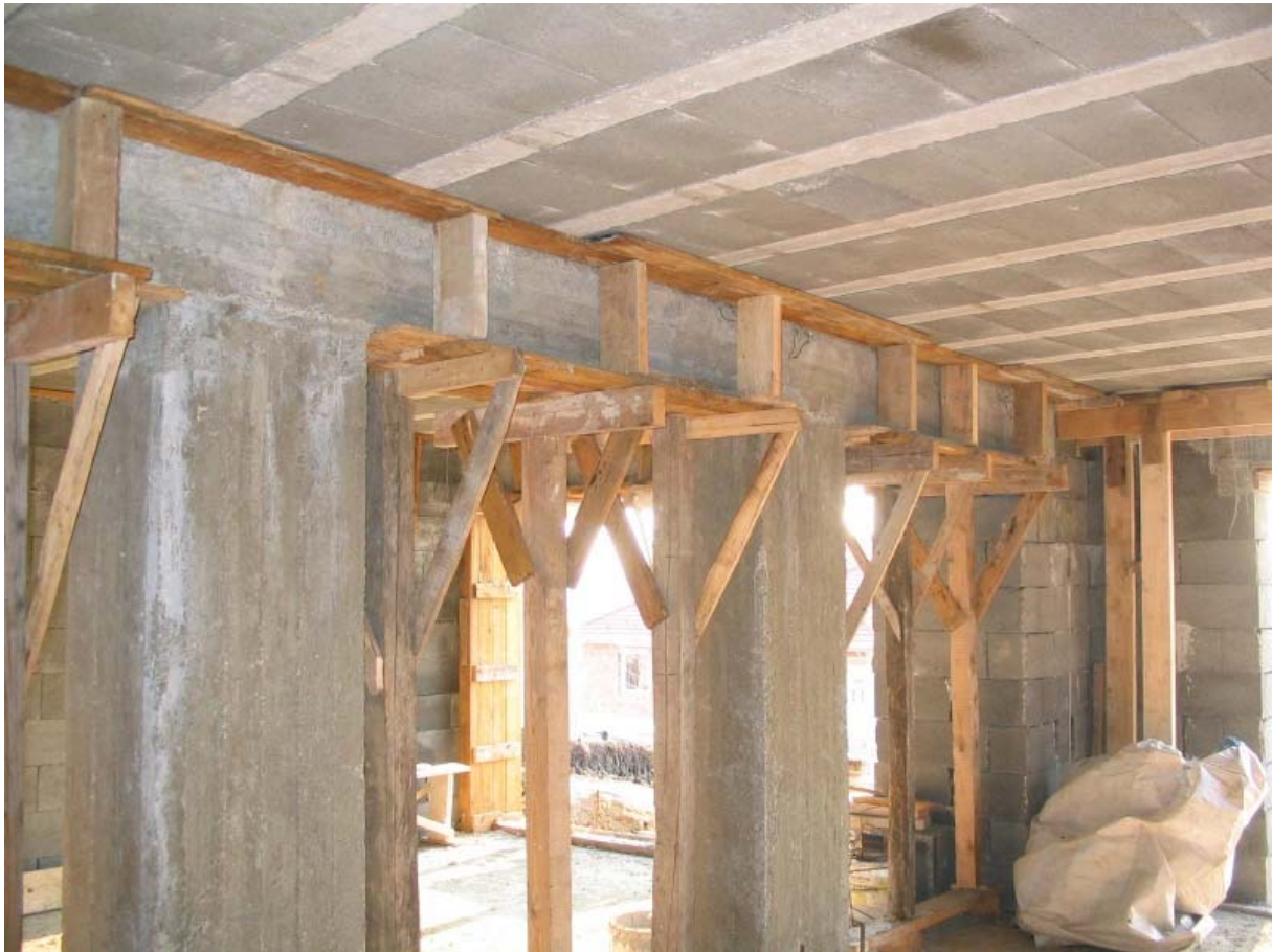
11. ábra. Áthidaló gerenda alátámasztása
