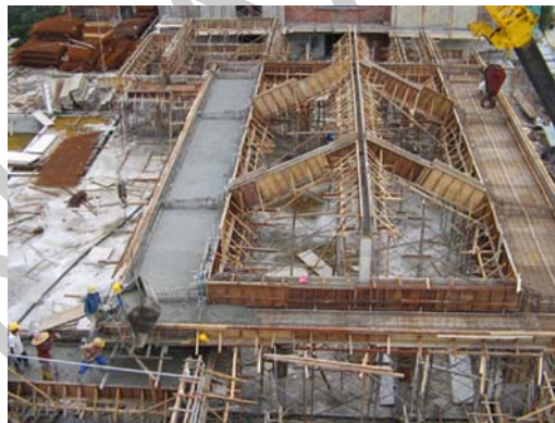
1. ábra. Építkezés monolit betonnal, hagyományos zsuzattal 1
