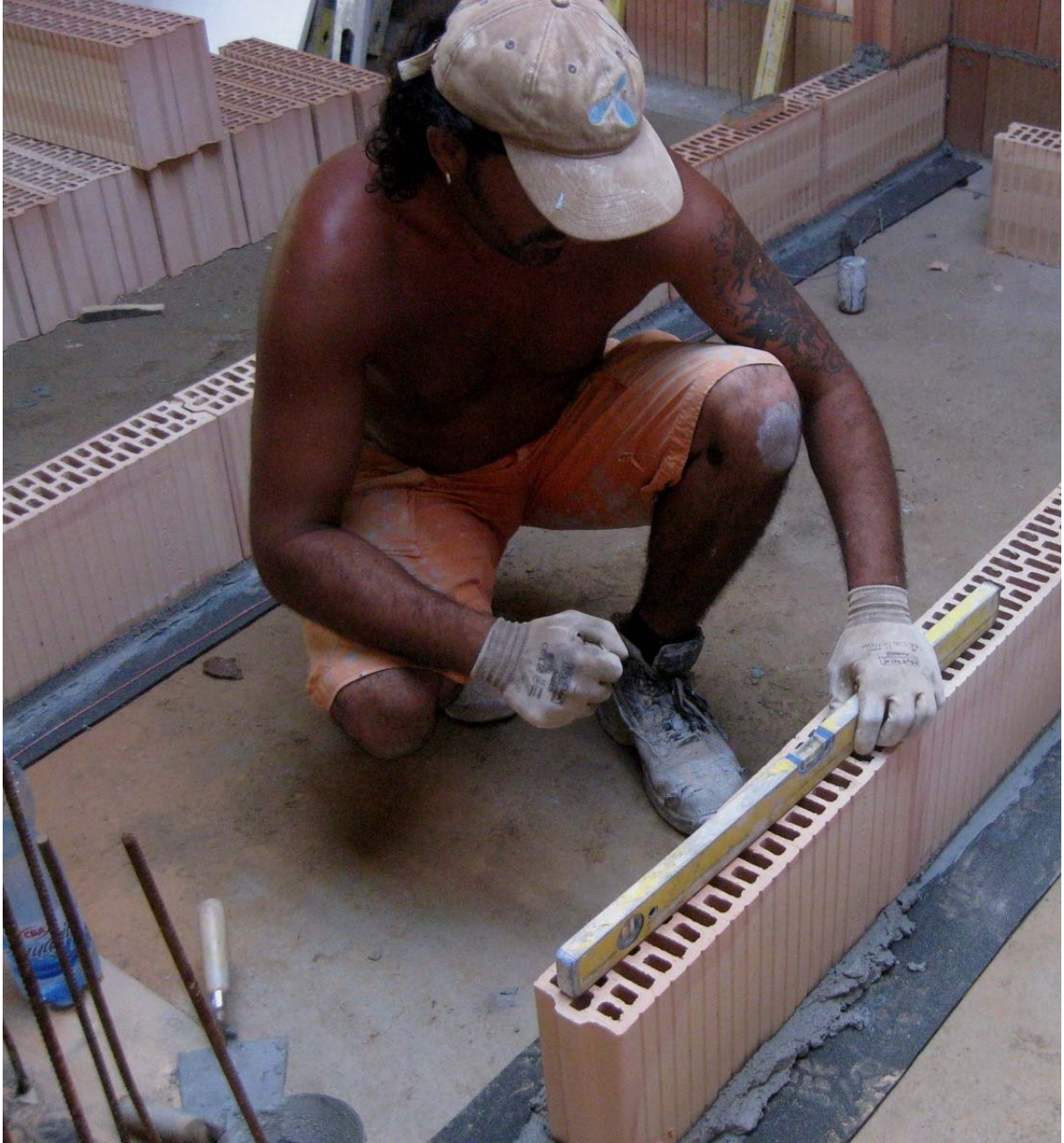
3. ábra Válaszfal falazás indító sorának készítése 3
