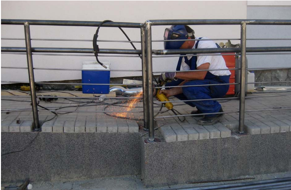
14. ábra Építés befejező munka, teraszkorlát készítése 15
