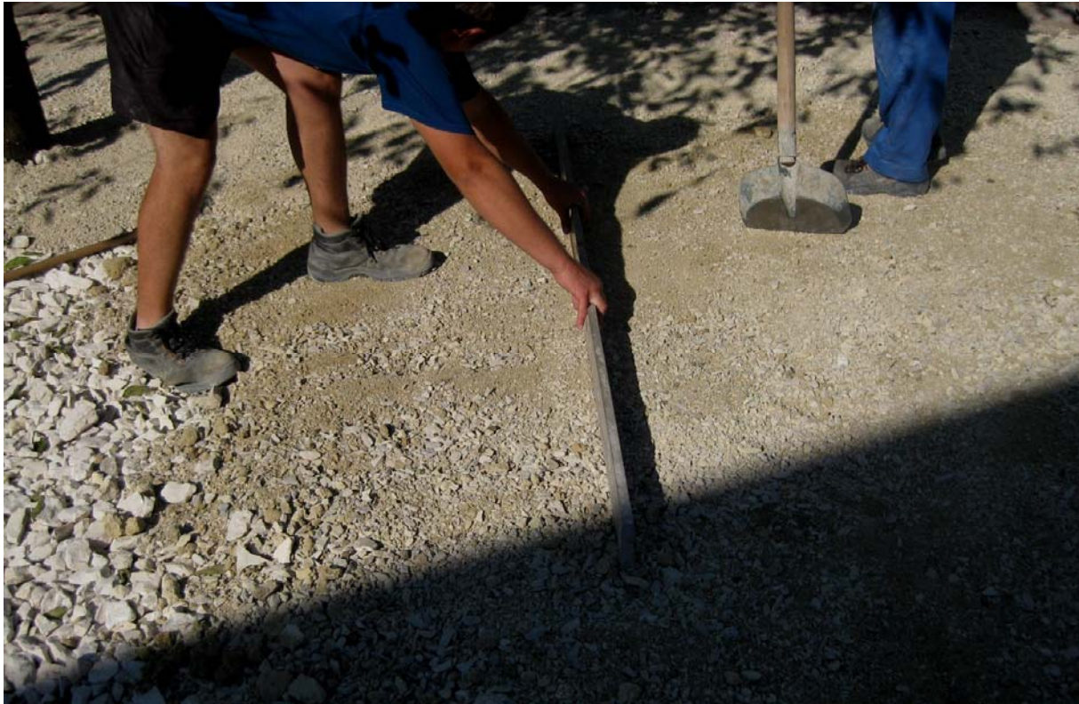
15. ábra Építés befejező munka, járda aljzatkészítés 16
