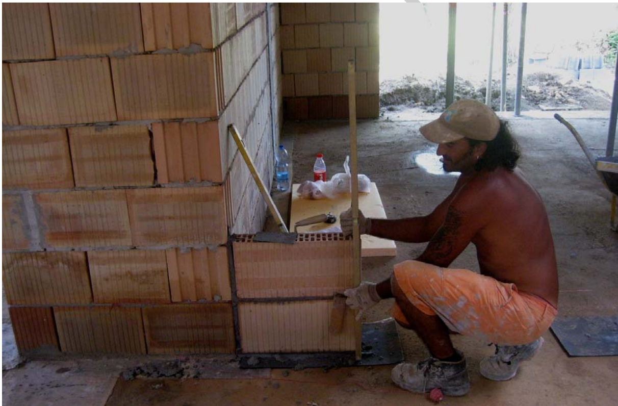
8. ábra Válaszfal falazás 9
