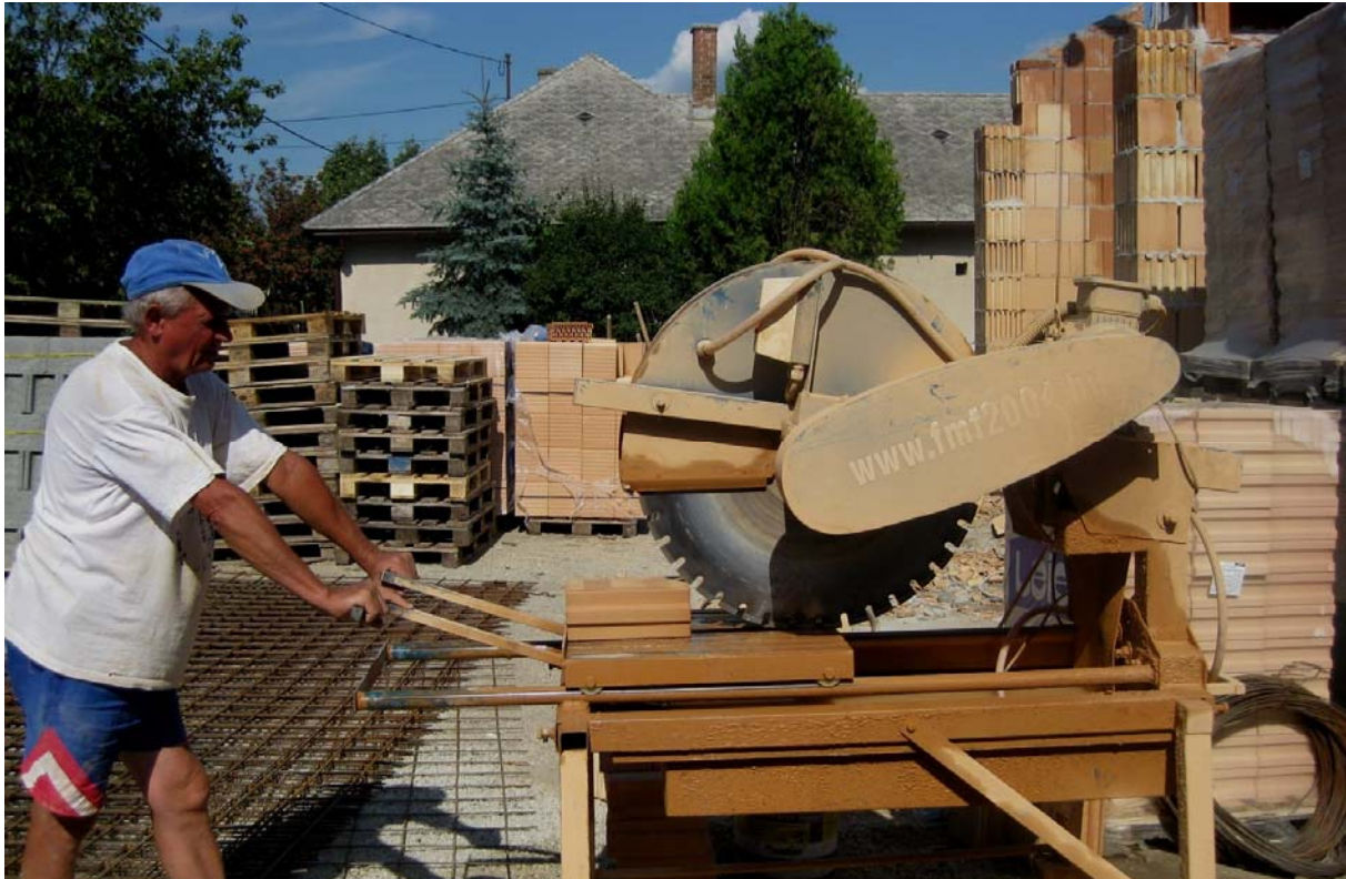
6. ábra Válaszfaltégla vágása téglavágógéppel 7
