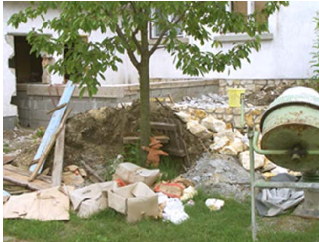
12. ábra. Építési terület 9
