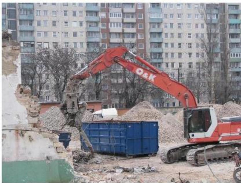
32. ábra, Épületbontás gépesített eljárással 33
