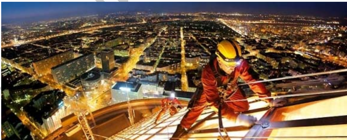
11. ábra. Éjszakai munkavégzés mesterséges megvilágítással 12
