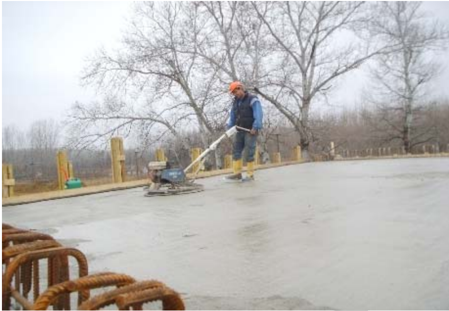
24. ábra. Tömörítés, simítás 25
