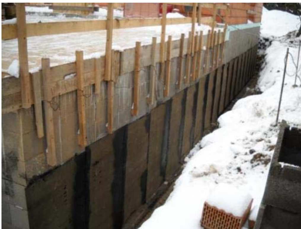
31. ábra. Vízszigetelés 32
