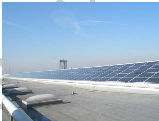
12. ábra Szinkron napelemes áramtermelő rendszer
