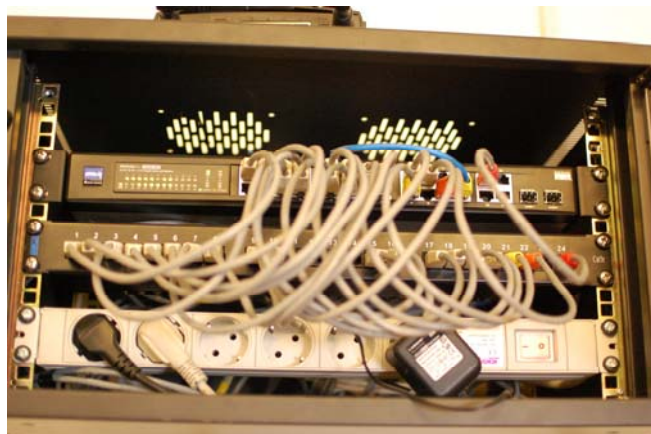
10. ábra. Aktív eszköz (switch) kommunikációs szekrényben
