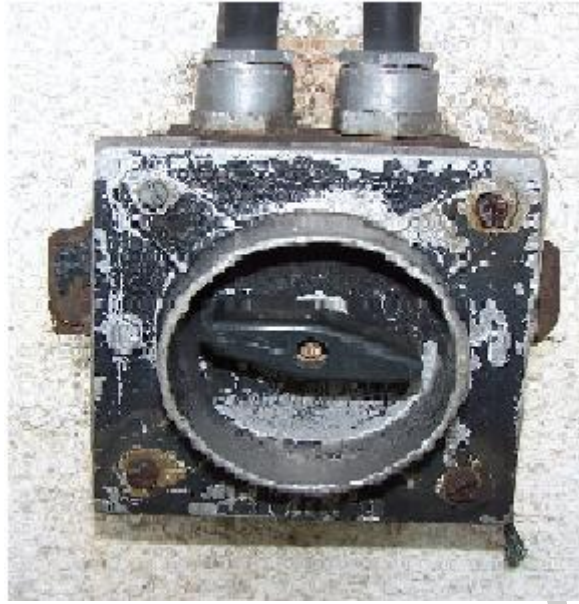
8. ábra. Tömített kivitelű kapcsolókészülék és szerelés
