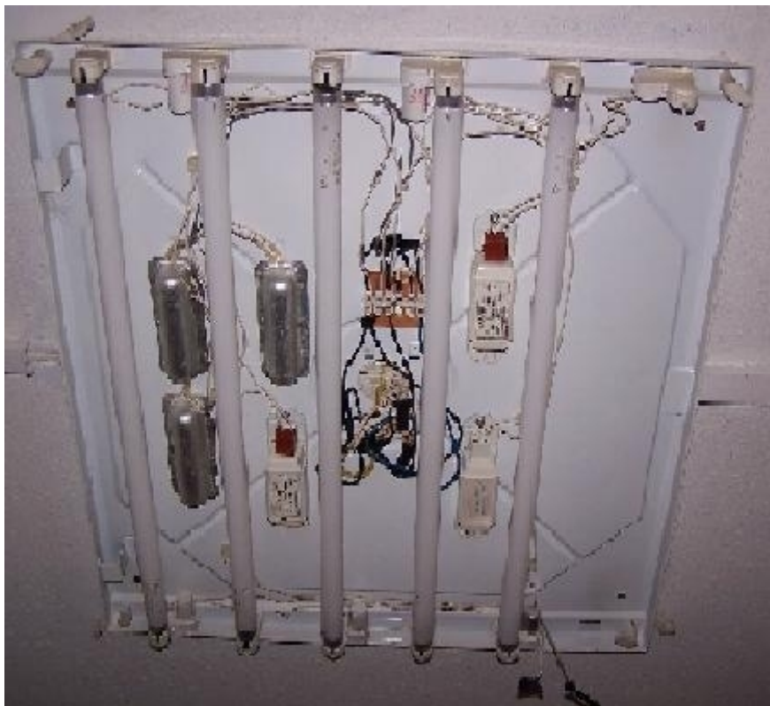
48. ábra. Fénycsöves világítás bekötése, huzalozása
