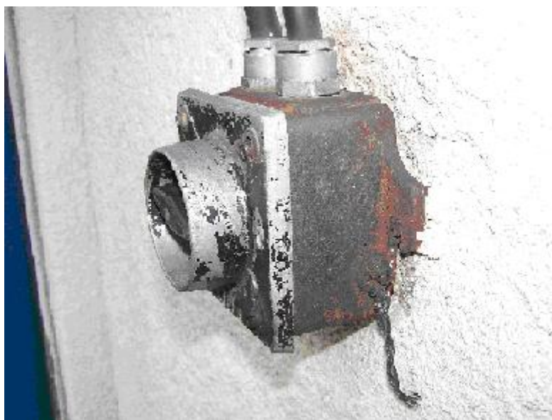
42. ábra. Kapcsoló érintésvédelmi vezetőjének bekötése
