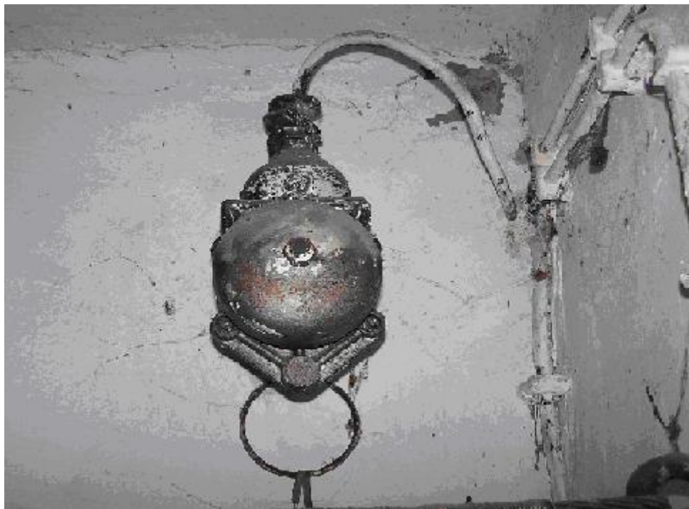
41. ábra. Kiskábeles szerelés
