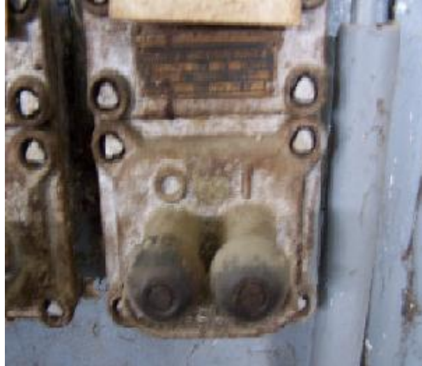
3. ábra Robbanásbiztos kivitelű nyomógomb
