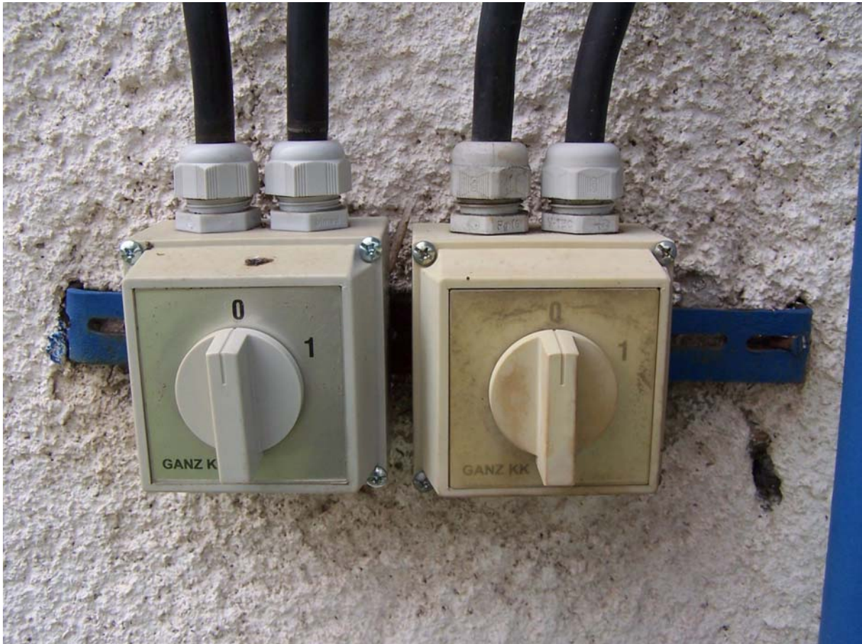
25. ábra. Külső fényforrásokat működtető kapcsolók
