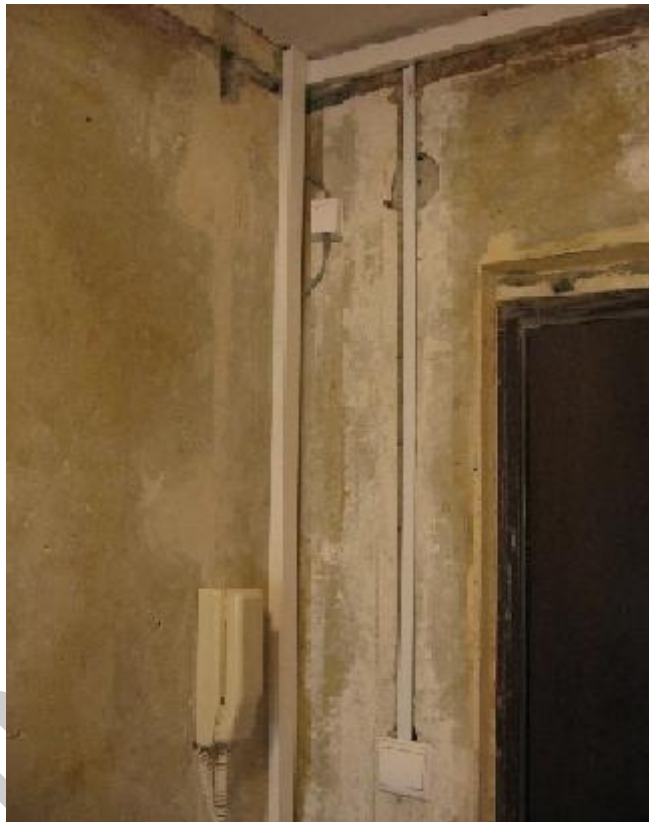
18. ábra. Síncsatorna alapszerelés
