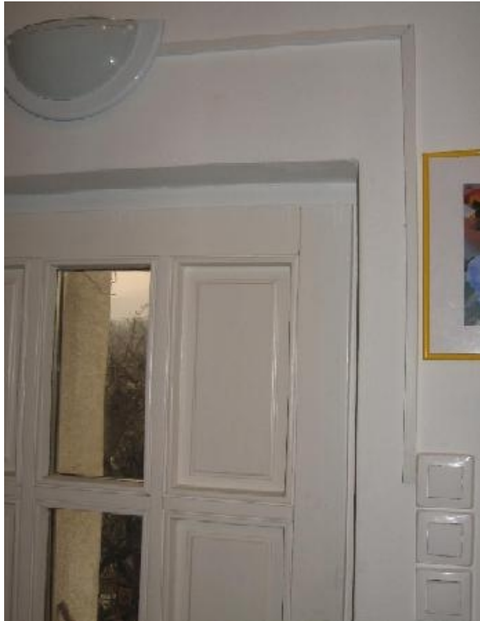
19. ábra. Síncsatornás szerelés lakásban
