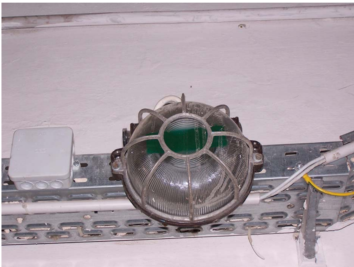
16. ábra. Vízmentes lámpatest felszerelése
