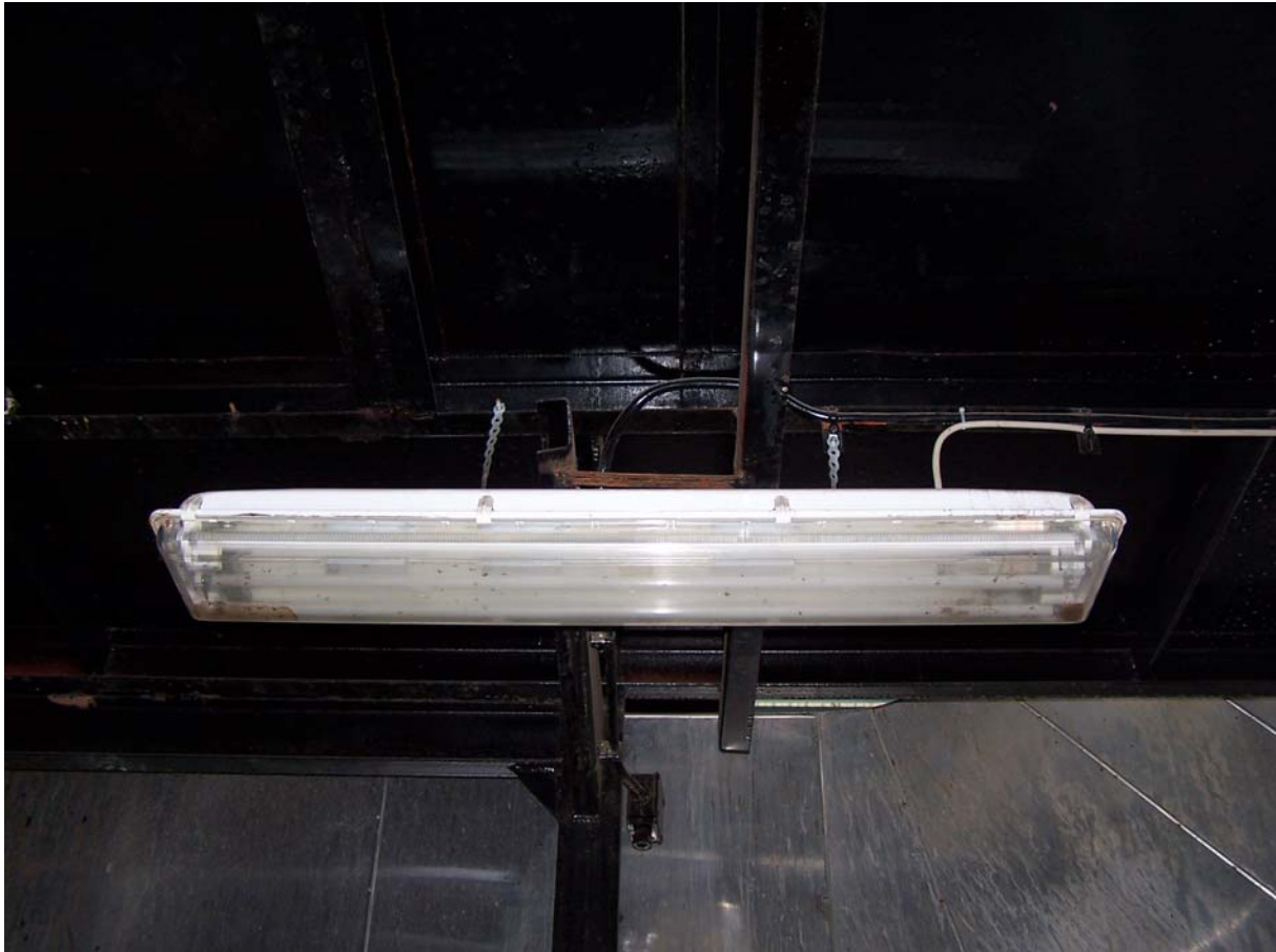
33. ábra Háromfázisú fénycső felszerelése
