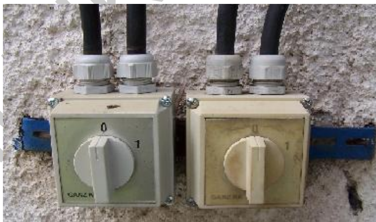
19. ábra Falon kívüli tömített szerelés
