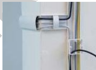
12. ábra. Vezeték elhelyezése a vezetékcsonnába
