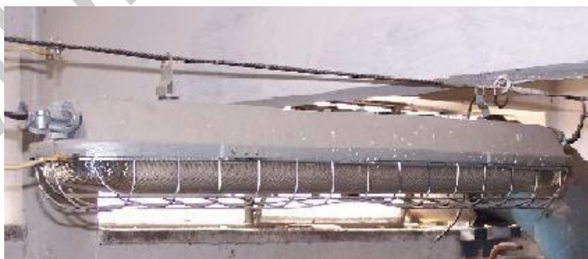
16. ábra. Feszített, kábelszerű vezeték alkalmazása
