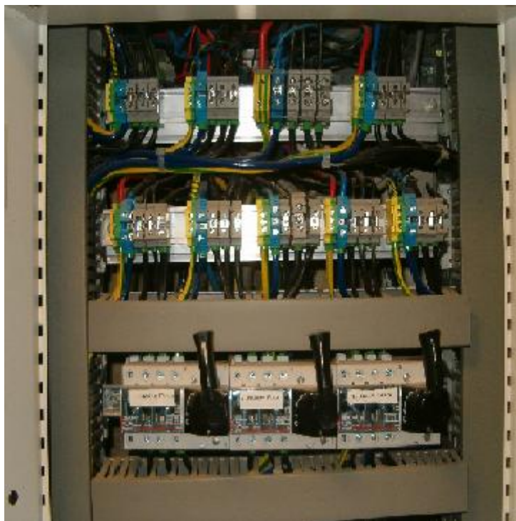
2. ábra. Főelosztó szerelvényezése
