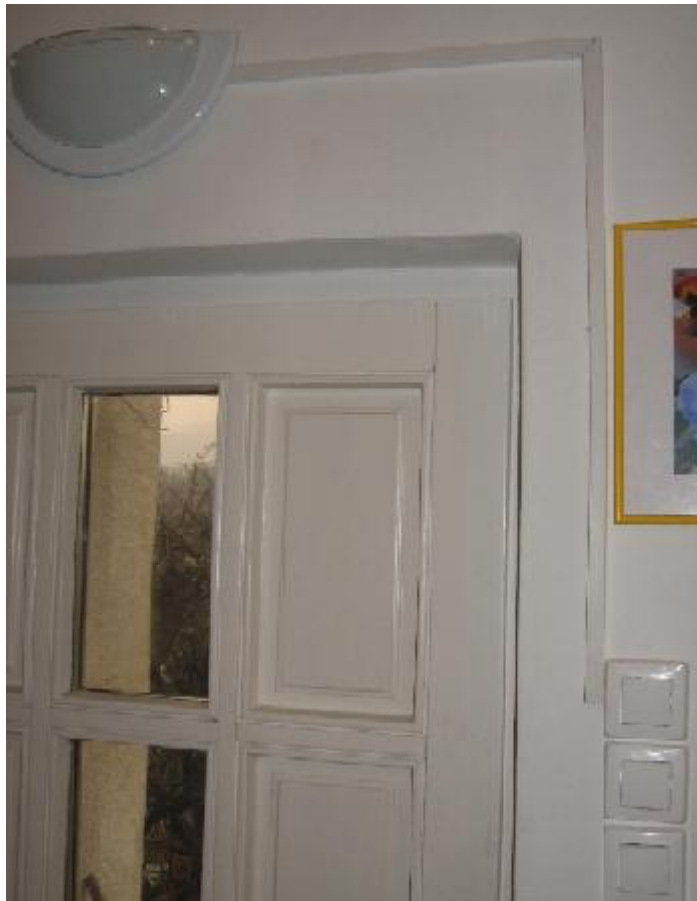
10. ábra. Vezetékcsatorna kiépítése világítási áramkör esetén
