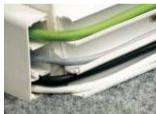
13. ábra. Osztott vezetékcsonás szerelés
