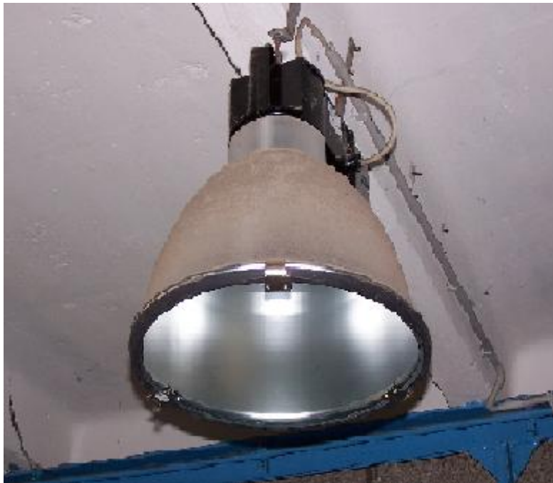
18. ábra Reflektoros világítás falon kívüli megtáplálással.
