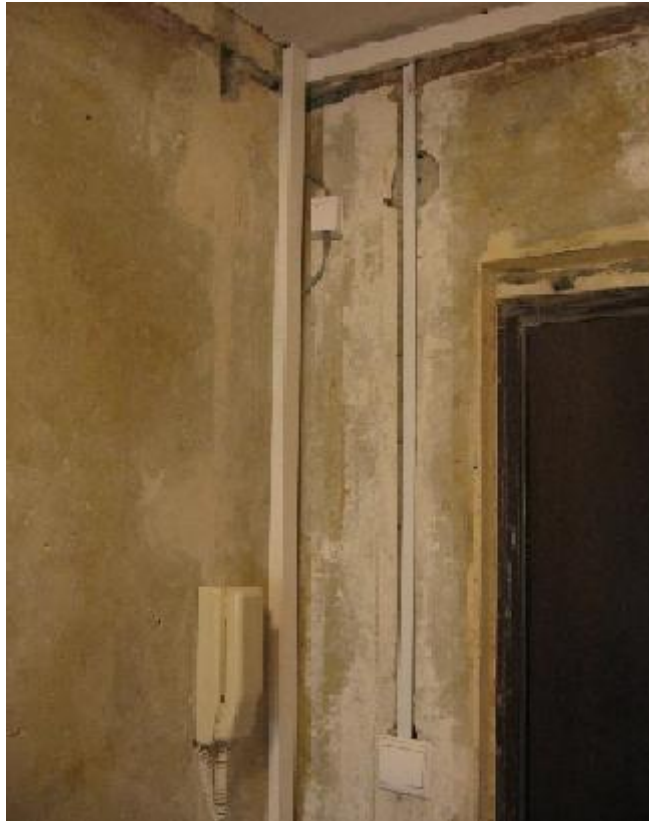
11. ábra. Vezetékcsatorna kiépítése
