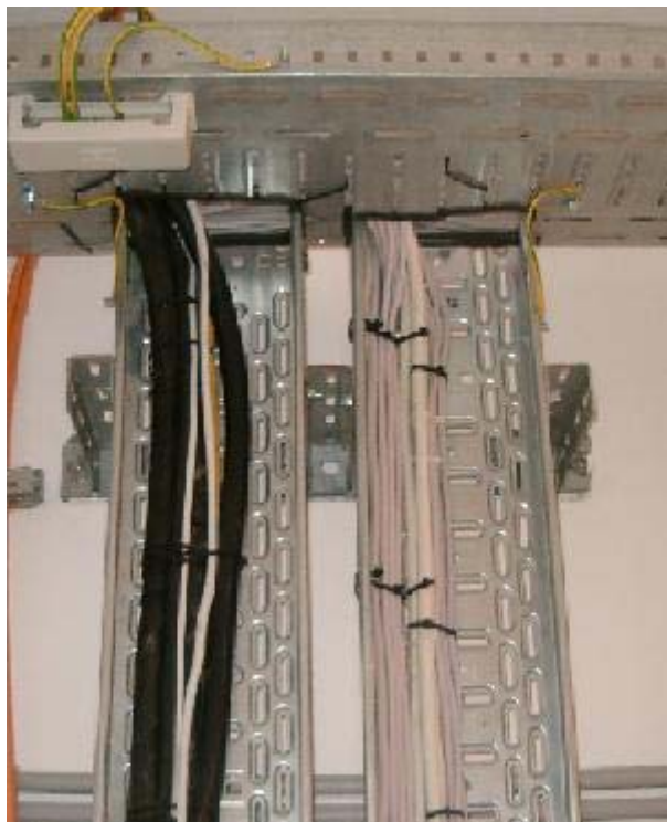
15. ábra. Szerelőlapos – kábeltálcás – falon kívüli szerelés
