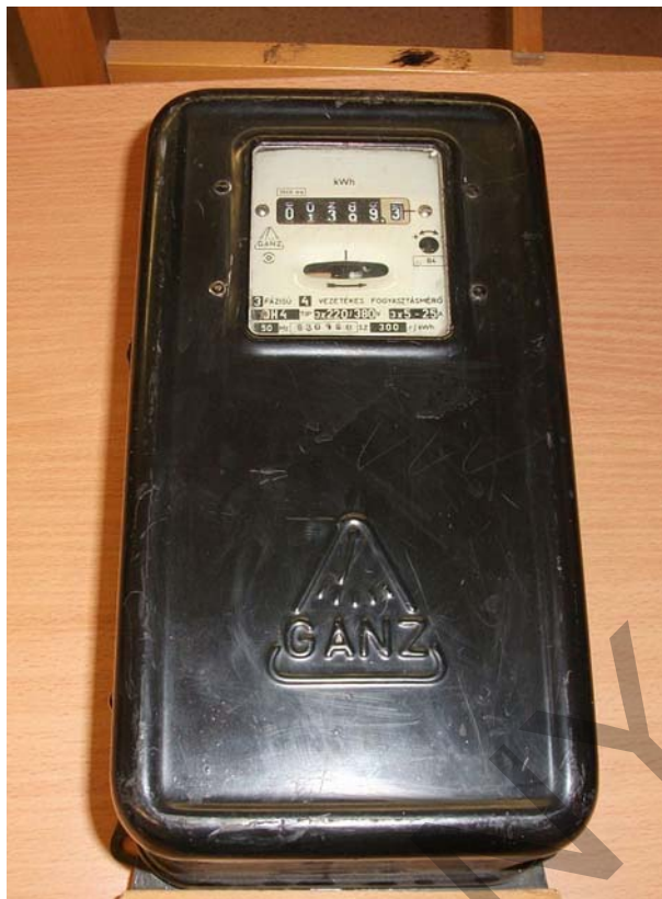
28. ábra. Háromfázisú indukciós elven működő fogyasztásmérő
