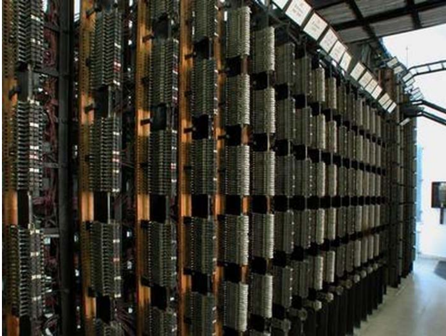
3. ábra. Hagyományos rézalapú (Krone) rendezősor
