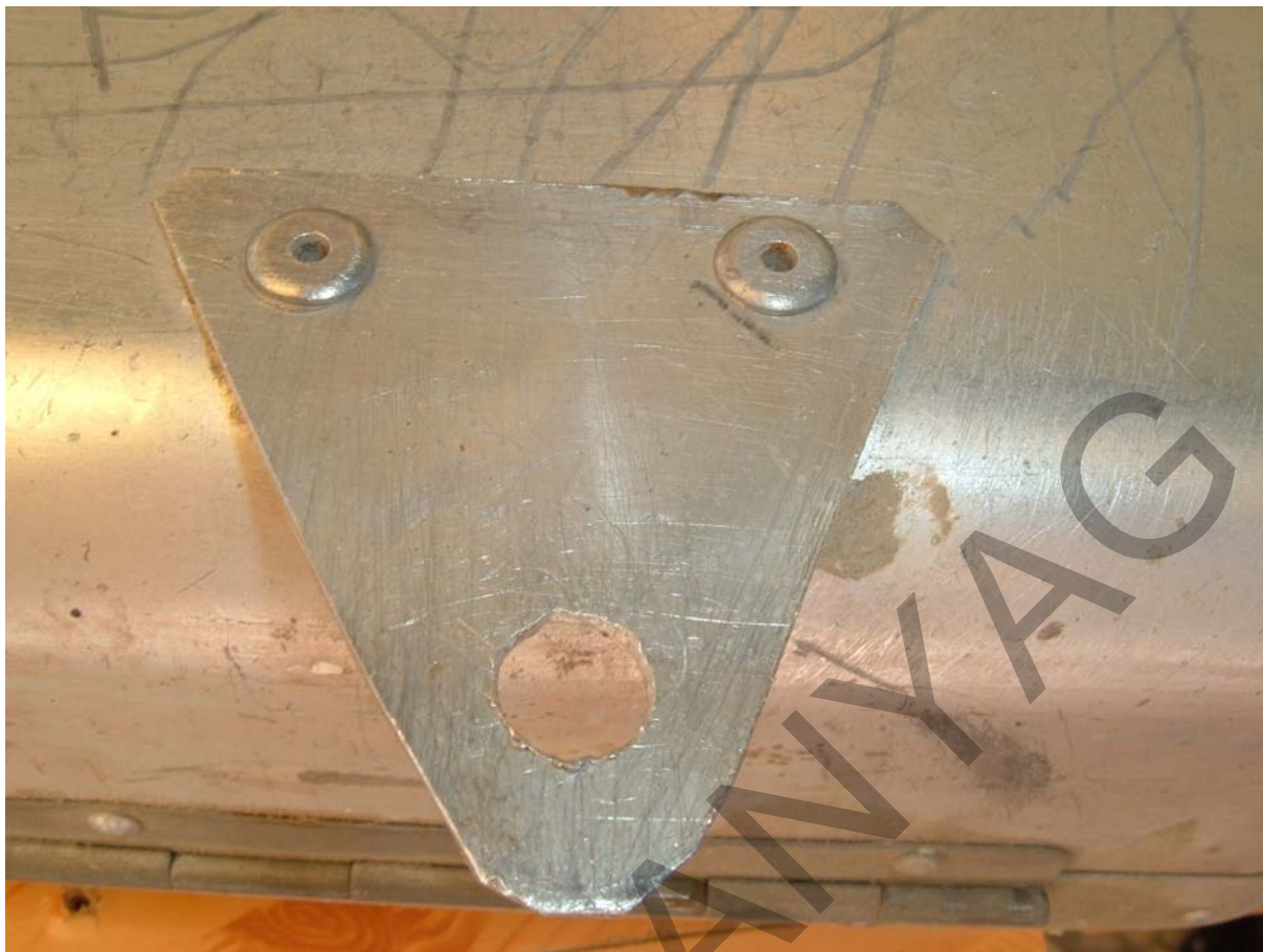
34. ábra. Záró szegecs (POP szegecs) képe a szerelés oldaláról
