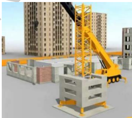
1. ábra. Toronydaru szerelése 1
