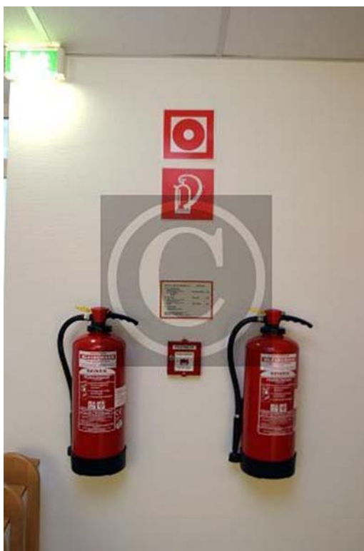
23. ábra. Tűzoltó készülék elhelyezése és jelölése 23
