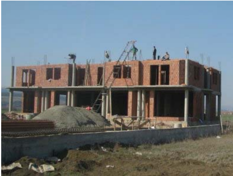
5. ábra. Építési munkaterület
