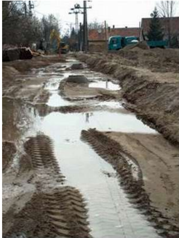
2. ábra. Építési munkaterület
