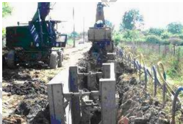
4. ábra. Munkaárok készítése
