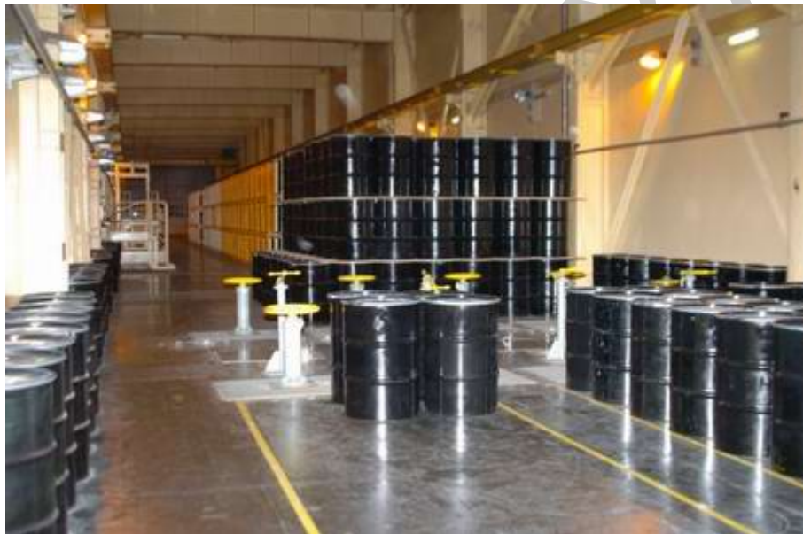
10. ábra. Paksi atomerőmű – hulladéktárolás
