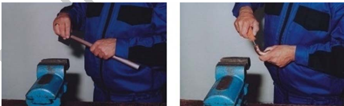
15. ábra. Csővég- és fitting tisztítás 14
