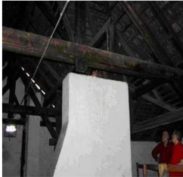
3. ábra Elfogyott a téglá? Az égéstermék a padlástérbe távoznak
