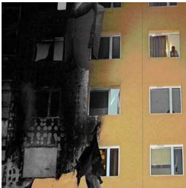
4. ábra. Gázkészülék okozta lakástűz
