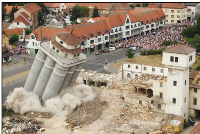
3. ábra Robbantással bontott gabonasíló (Kecskemét) a lezuhanó tömeg
