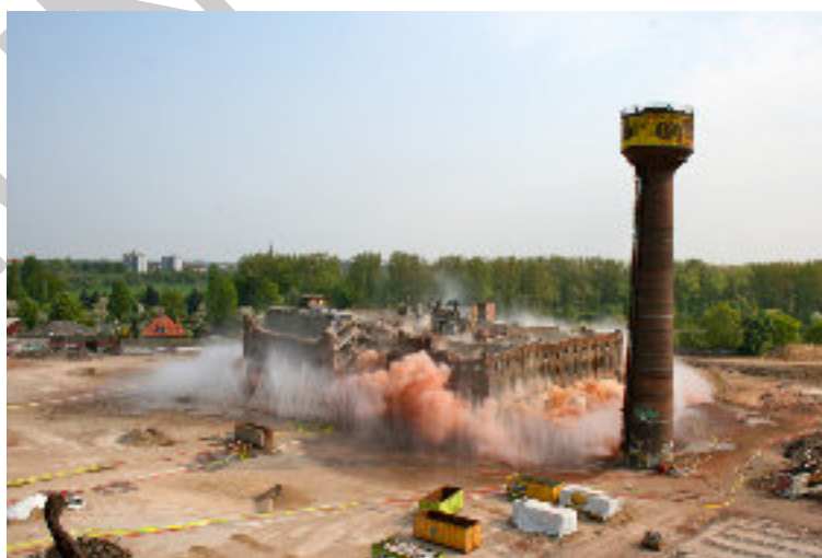
2. kép Jól áttekinthető robbantási környezet vízfüggönnyel történő porlekötéssel
