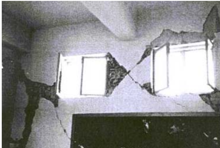
9. ábra. Jellemző repedéskép szeizmikus kár esetén
