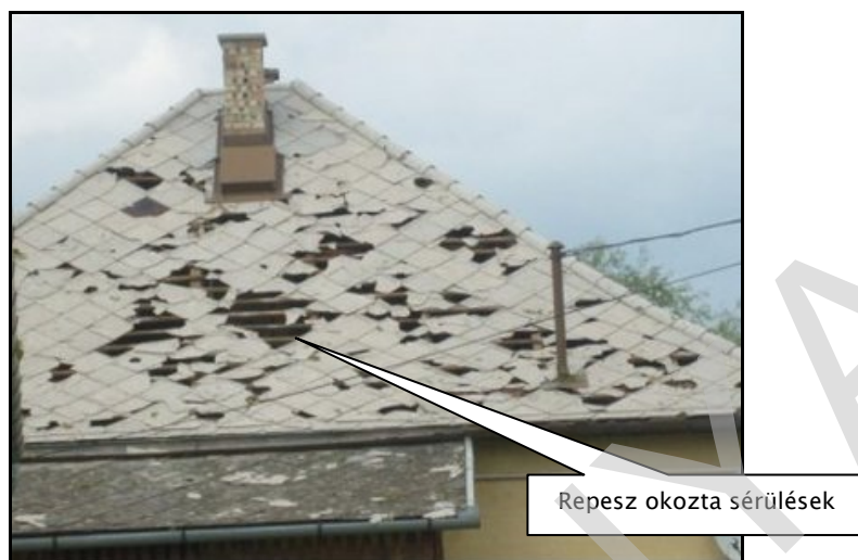
2. ábra Repeszszerült tetőhéjzat
