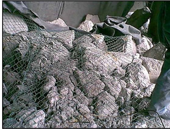
9.ábra Drótfonatból és geo textiliából kialakított repeszfogó gépalap robbantásnál
