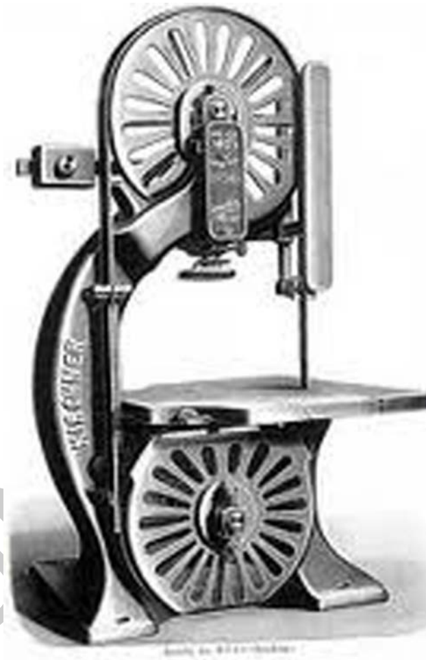
8. ábra Szalagfűrészgép 8
