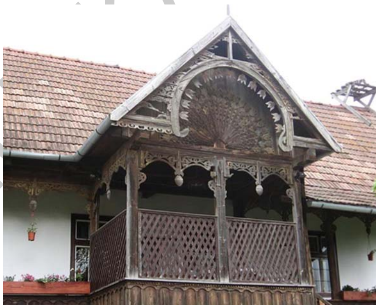
19. ábra Kalotaszegi tornácos ház
