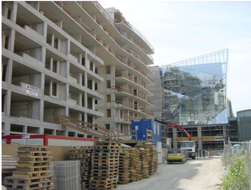
9. ábra Utak kialakítása az építkezésen 9
