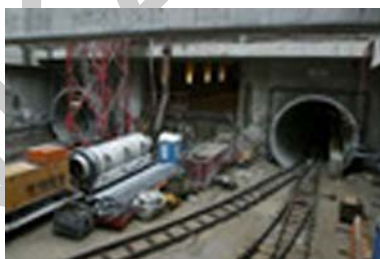
16. ábra. A budapesti 4-es metró építése 2
