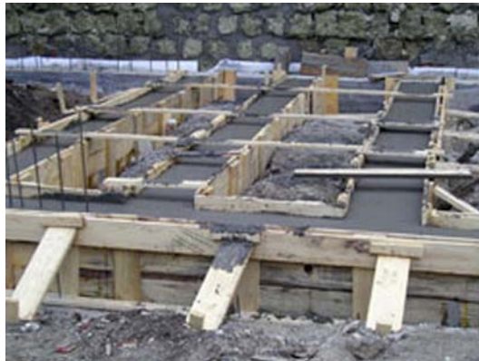
26. ábra. Talpgerenda betonozva, tömörítés után 5
