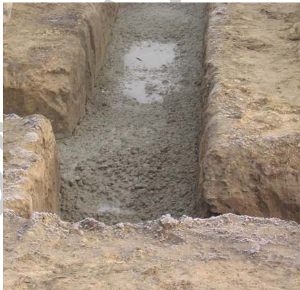
7. ábra. Sávalap betonozása 7
