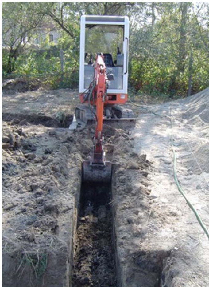
9. ábra. Épület alapjának „kimarkolása” 9
