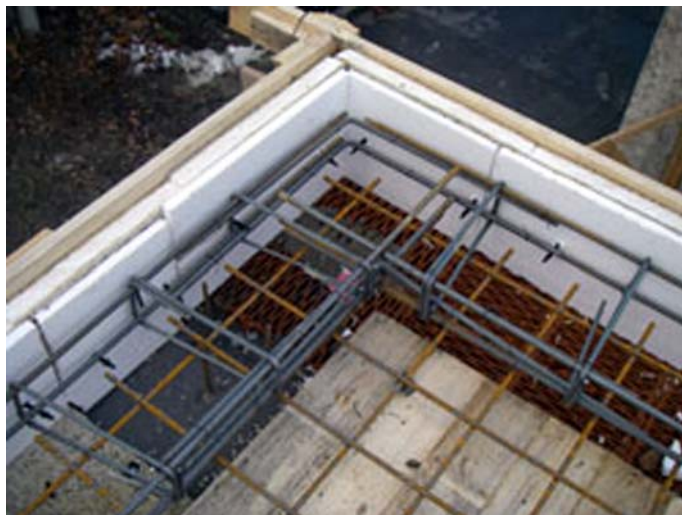
8. ábra. A koszorúvasalás, valamint a kettős (HERATEKTA + NIKECELL) hőszigetelés látszik a koszorún 8
