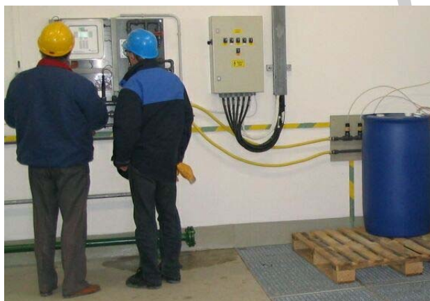
4. ábra. Műszaki átadás-átvétel 4
