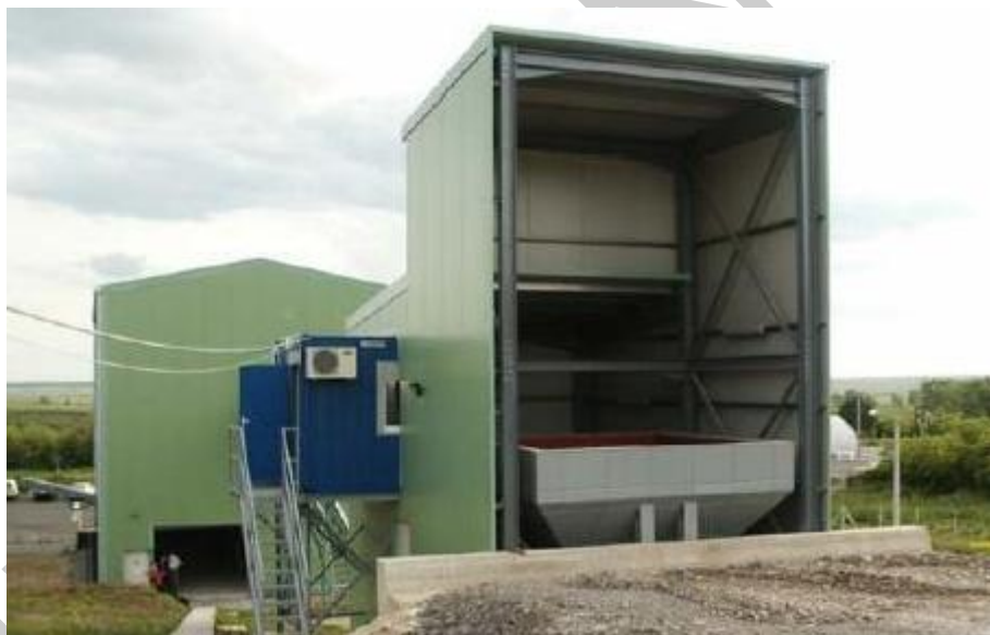
4. ábra. Az építési törmeléket fogadó garat 2
