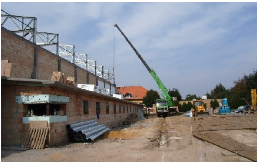
8. ábra. Acéltartók elhelyezése mobil daruval 9
