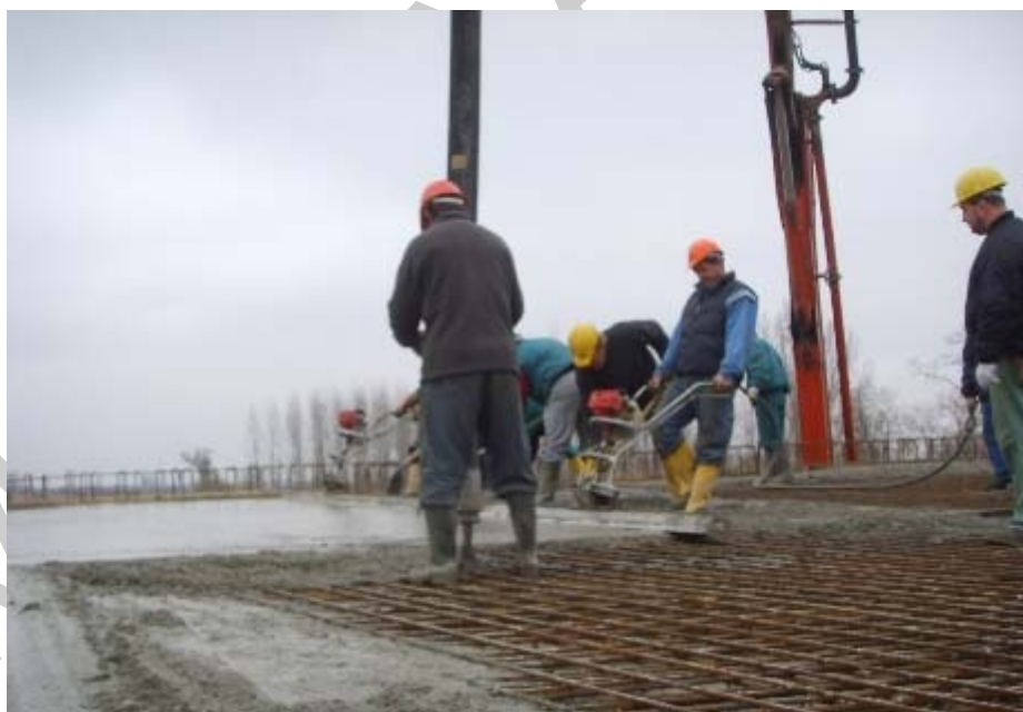
23. ábra. Betonozás folyamata 24
