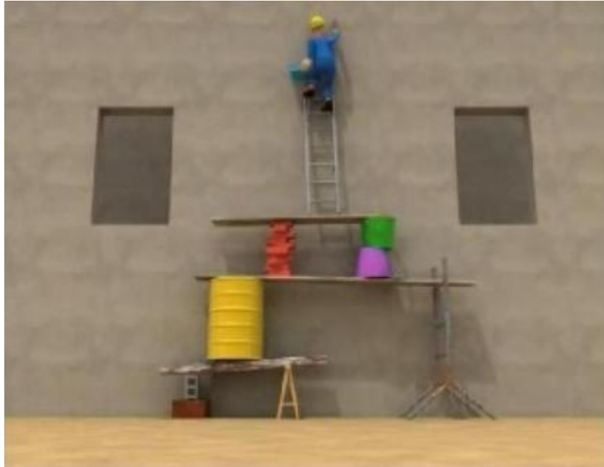
29. ábra. Balesetveszélyes segédszerkezet festéshez 30
