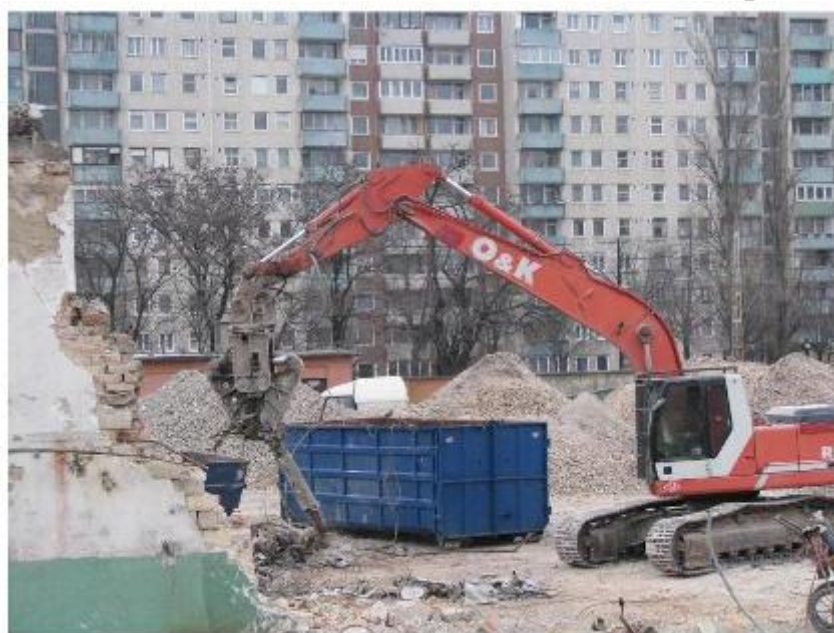
32. ábra, Épületbontás gépesített eljárással 33
