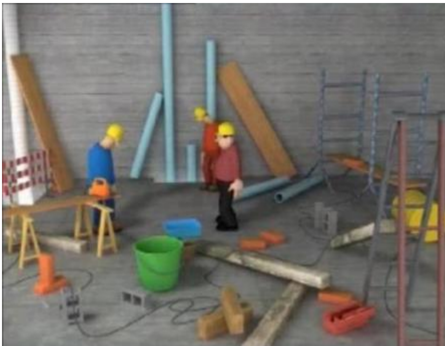
14. ábra. Építési anyagok tárolása célszerűtlenül 15
