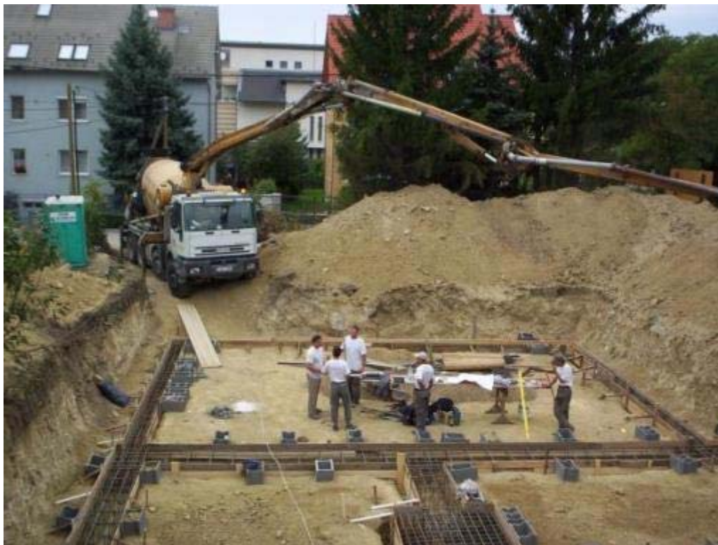
22. ábra. Betonozásra előkészített munkaterület 23
