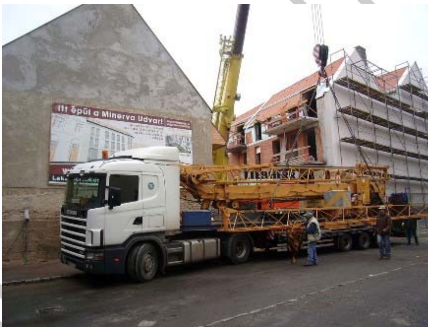
9. ábra. Toronydaru-elem beemelése 10
