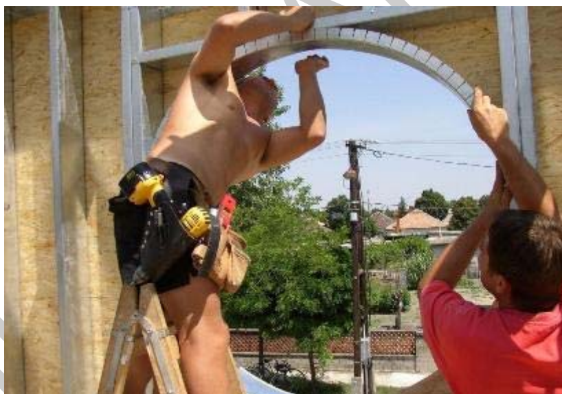
17. ábra. Balesetveszélyes, helytelen és hiányos öltözk 18
