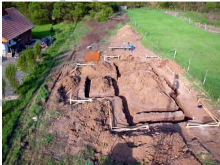
20. ábra. Zsinórállás, alapsík földkitermelése 21
