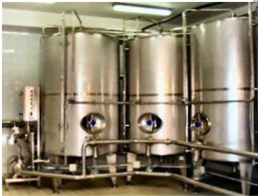
2. ábra. Zárt rendszerű köráramoltatásos tisztogató központ (CIP) 5
