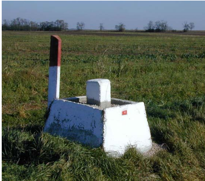
6. ábra. Országos vízszintes alappont vasbetonlapos védőberendezéssel
