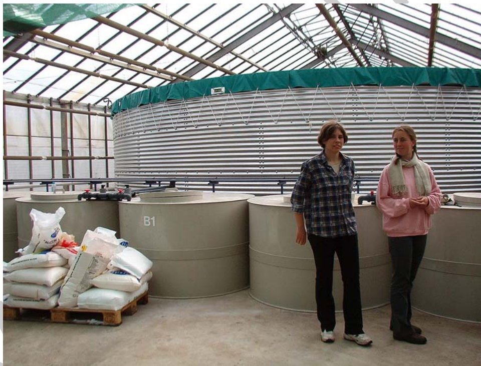
17. ábra. Üvegházi víztározó (háttérben) és a tápoldatozáshoz szükséges törzsoldatok tartályai (előtérben)
