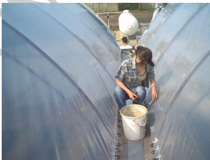
12. ábra. A fólia rögzítése műanyag kapsokkal a vápacsatornában
