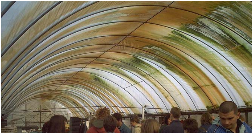
14. ábra. A belső fólián kiváló szennyeződés a vízfüggönyös fóliasátor esetében
