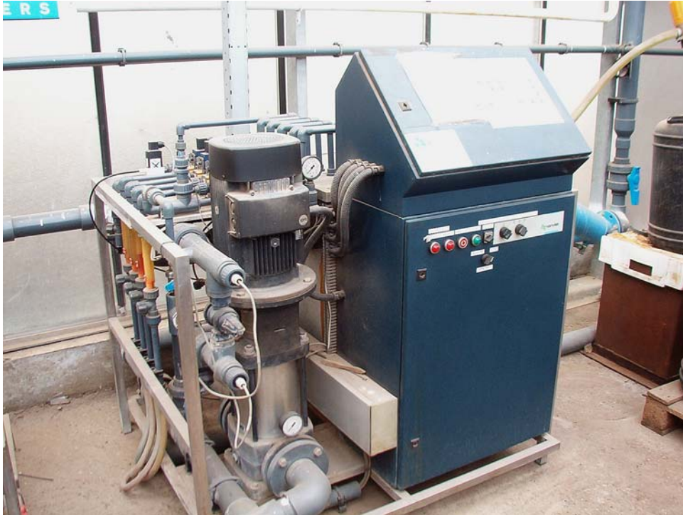
18. ábra. Az öntözést és a tápoldatozást irányító számítógépes rendszer
