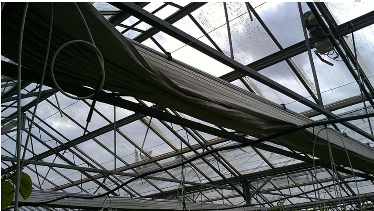
3. ábra. Automatizáltan mozgatott energiaernyő
