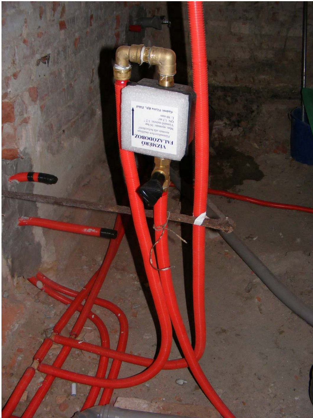
16. ábra Vízmérő felszerelése
