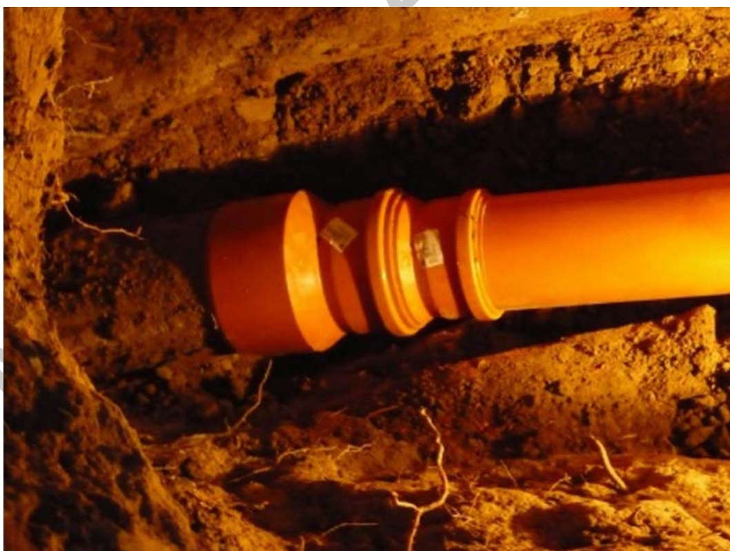
21. ábra Különféle anyagú, átmérőjű csövek összekötése
