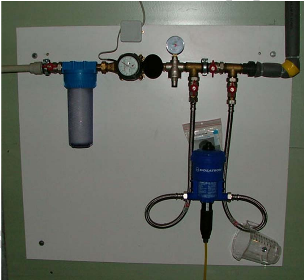
56. ábra Baromfi itatók nyomásszabályozó egysége
