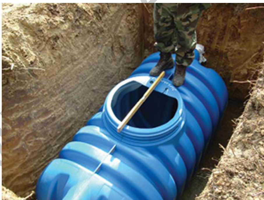
3. ábra Csapadékvíz tároló tartály
