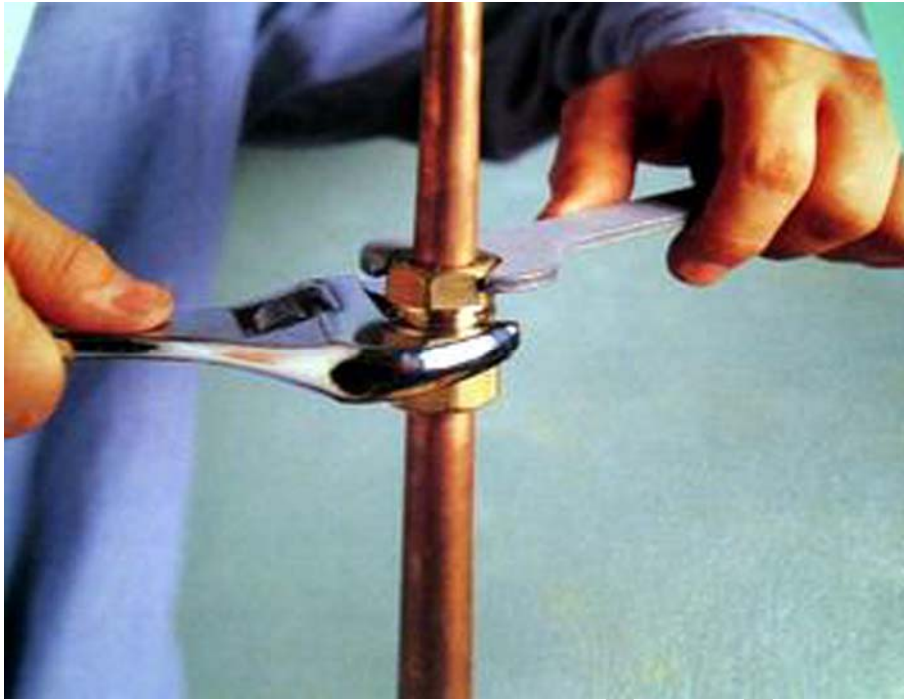
17. ábra Rézcső kötése
