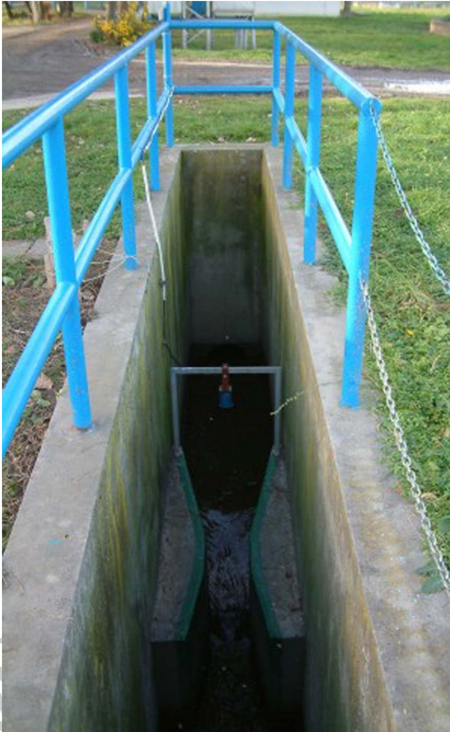
29. ábra Tisztított szennyvíz ellenőrzése, mérése
