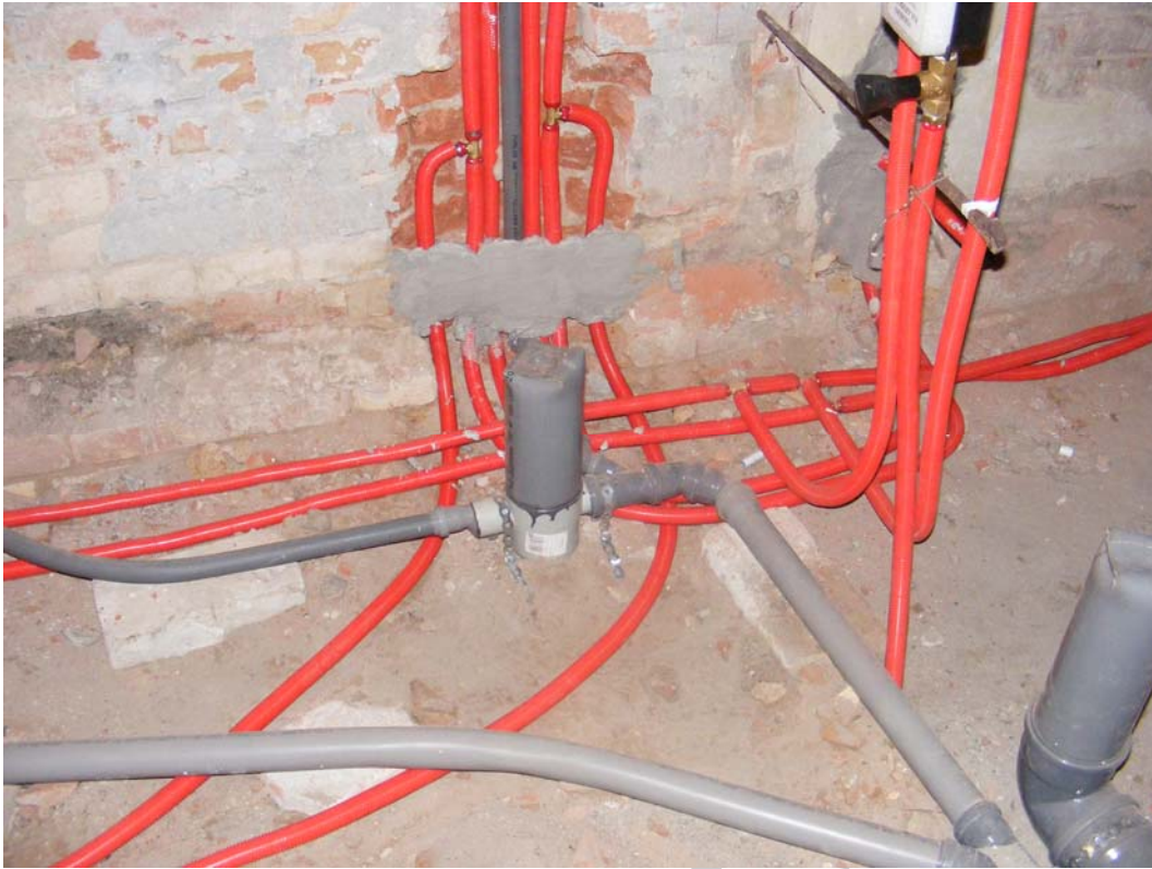
15. ábra Vízvezeték és lefolyó szerelése
