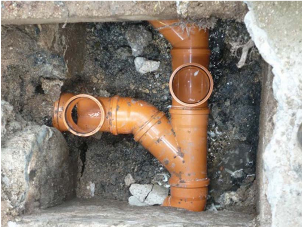
22. ábra Szerelés padozat alatt (aknában)
