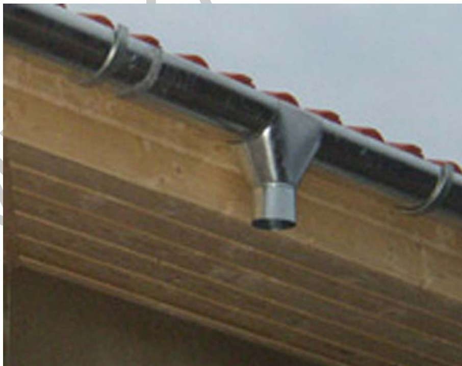
22. ábra Esőcsatorna levezető
