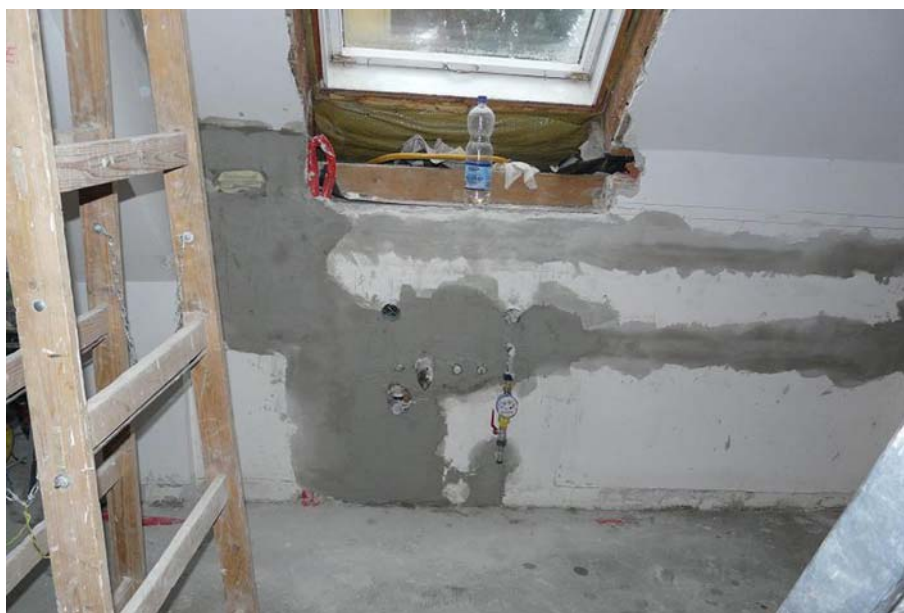
15. ábra Javított falfelület
