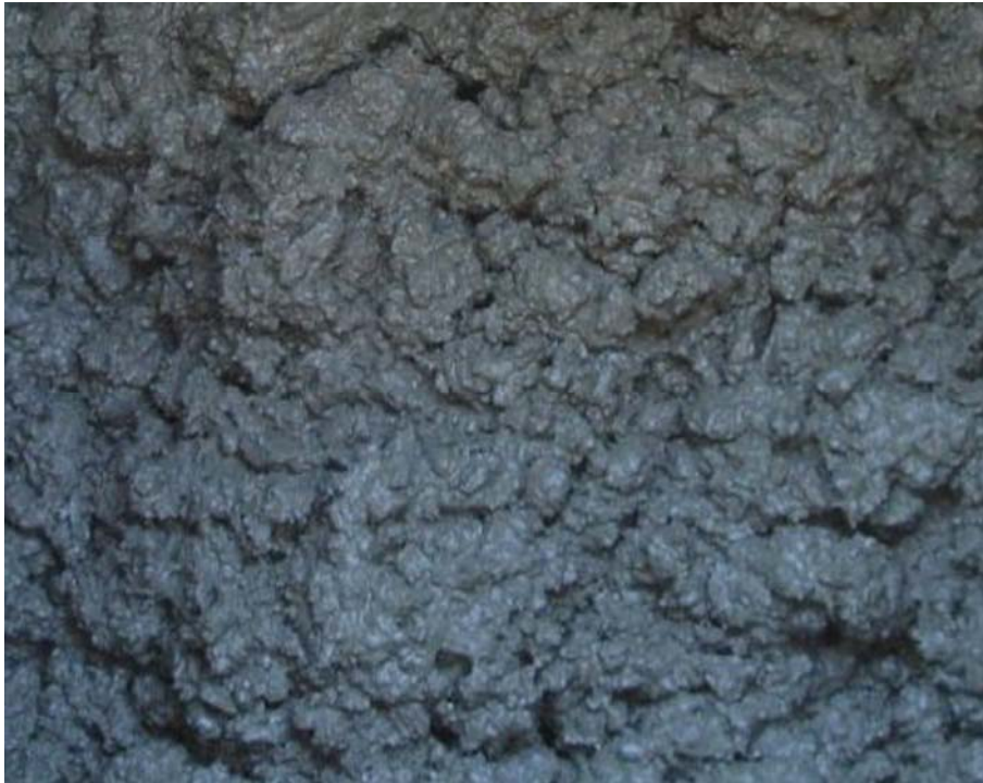
18. ábra Frissen kevert beton
