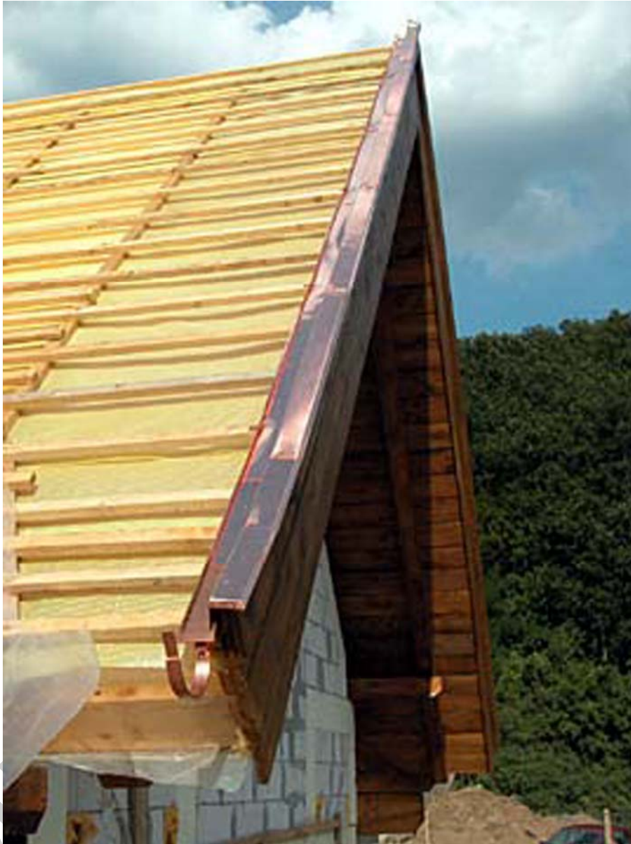
23. ábra Orom bádogfedése vörösréz lemezzel
