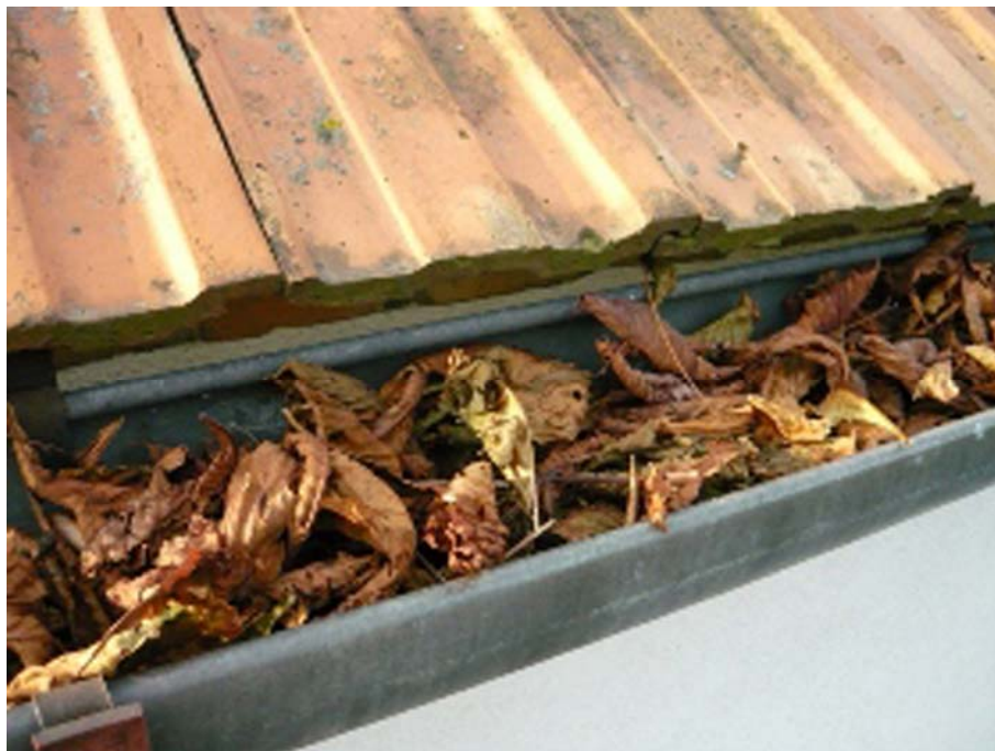
24. ábra Lombbal telített csatorna
