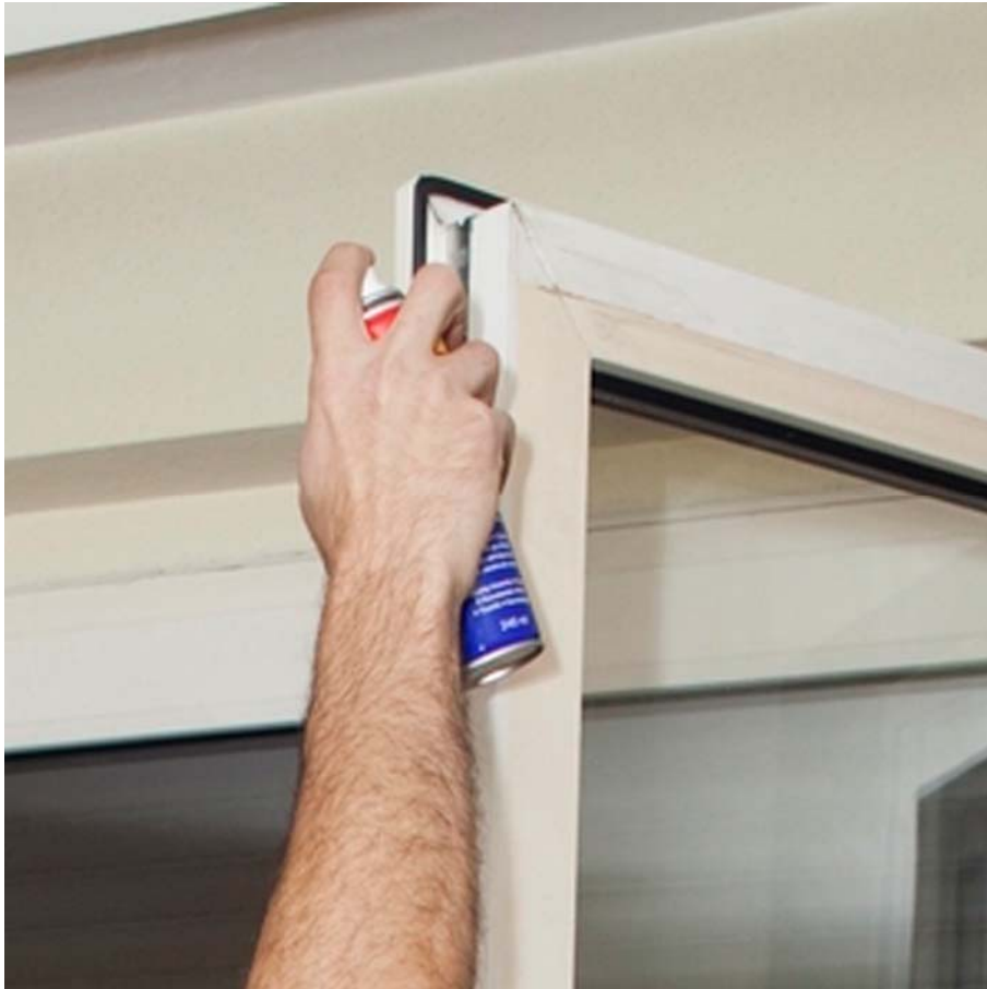
27. ábra Vasalatok olajozása
