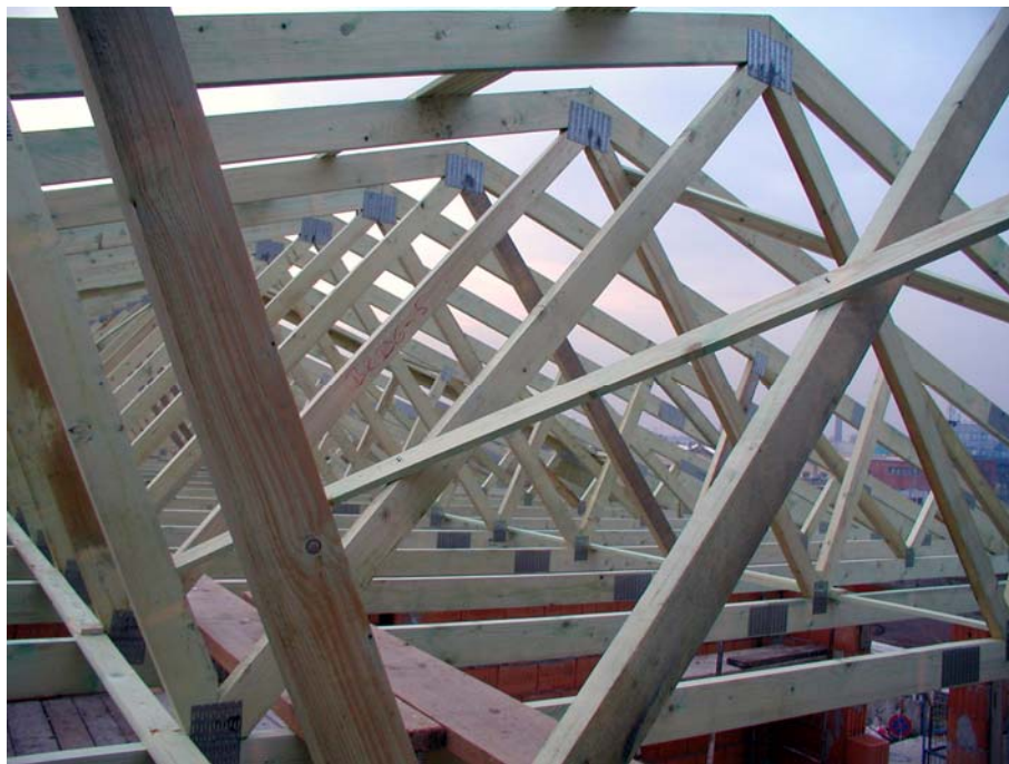
21. ábra elkészült tető ácsolat
