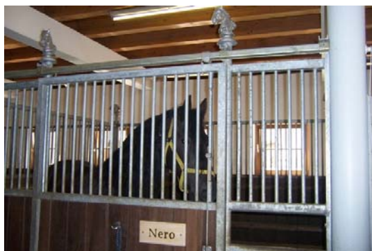
4. ábra. Bokszfal fából, ráccsal kiegészítve
