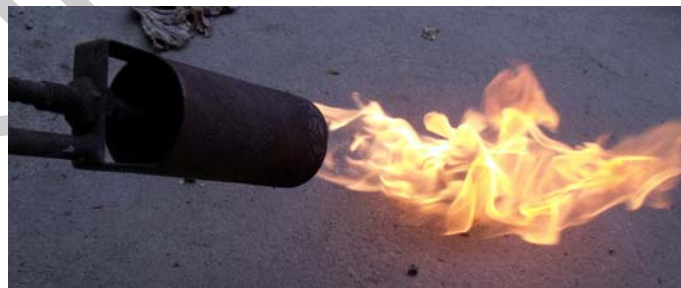
4. ábra. Beton padozat leégetése
