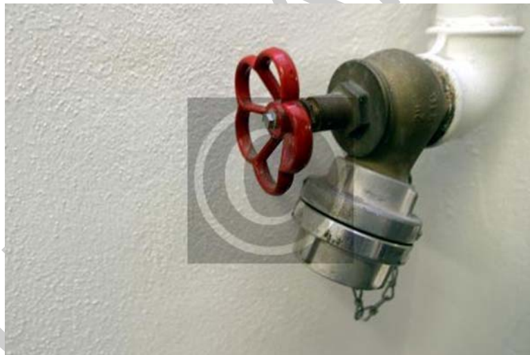
12. ábra. Fali tűzcsap 12
