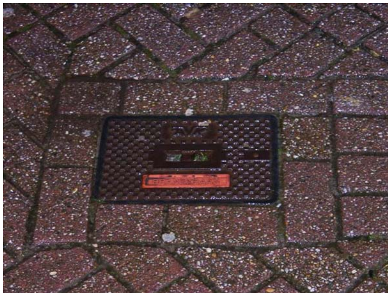
19. ábra. Föld alatti tűzcsap 19
