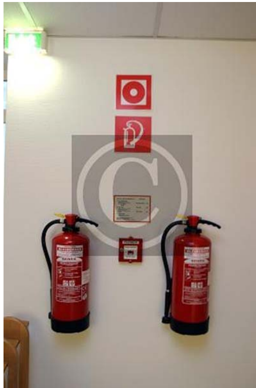
23. ábra. Tűzoltó készülék elhelyezése és jelölése 23
