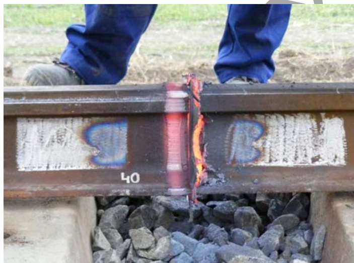
2.ábra. Frissen hegesztett vonatsínek, a hegesztett kötés még izzik
