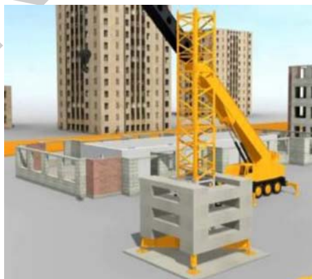
1. ábra. Toronydaru szerelése 1
