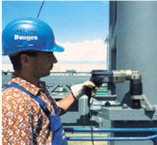
4. ábra. Elektromos nyomatékkulcs gépek acélszerkezeti munkáira 4
