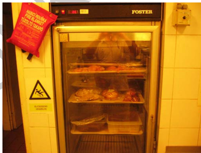
16. ábra. Tűzveszély elhárítására megfelelő takaró kihelyezés.
