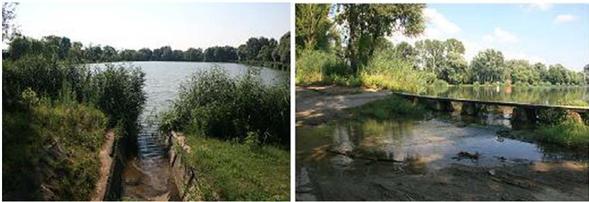
7. kép. Csapadékvíz bevezetése és a túlfolyó a tónál
