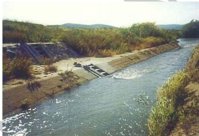
1. ábra. A vízmércék megközelítését lépcsők biztosítják
