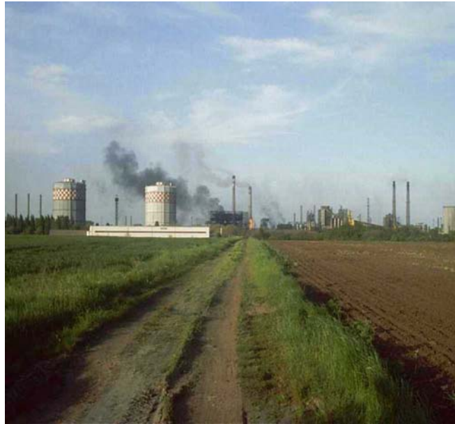
14. ábra. A gyárak okozta emisszió
