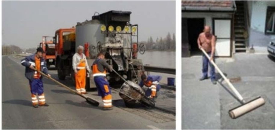
5. ábra. Munkavégzés aszfalthengerrel 4
