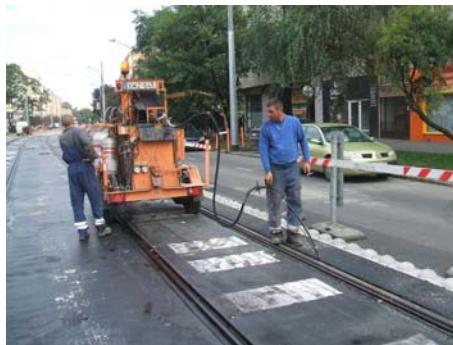
9. ábra. hézagkiöntőgép kiöntőpisztoly
