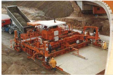
4. ábra. Csúszózsálas bedolgozás
