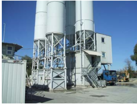
1. ábra. Betonkeverő látképe
