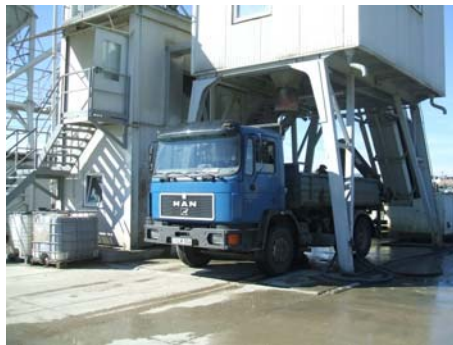
3. ábra. A beton kiadása
