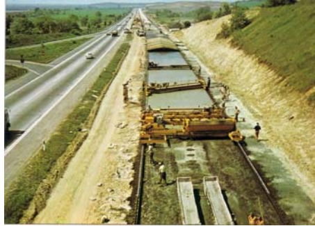
5. ábra. Formasínes bedolgozás
