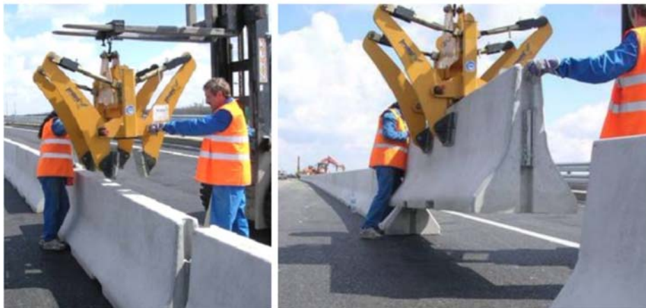
11. ábra. New Jersey betonelem targoncára szerelt speciális emelője 4
