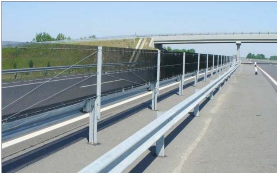
8. ábra. Fénytörő háló szabályos kijavítása 2
