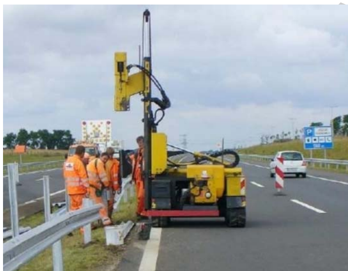
10. ábra. Korlátjavítás célgéppel autópályán
